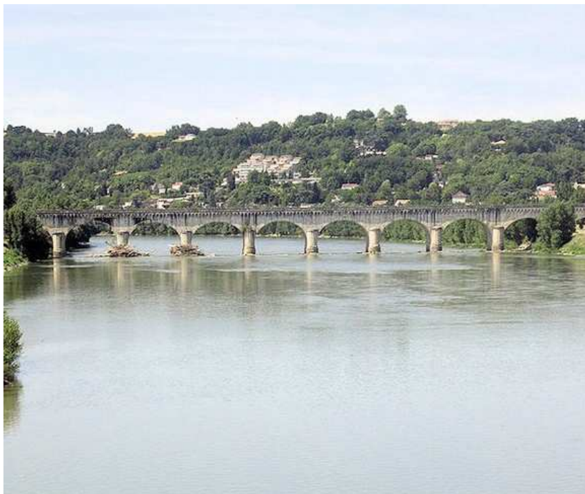
Le Pont-Canal d'Agen, qui a la particularité de faire passer la navigation au-dessus de la Garonne, via le canal latéral à la Garonne
