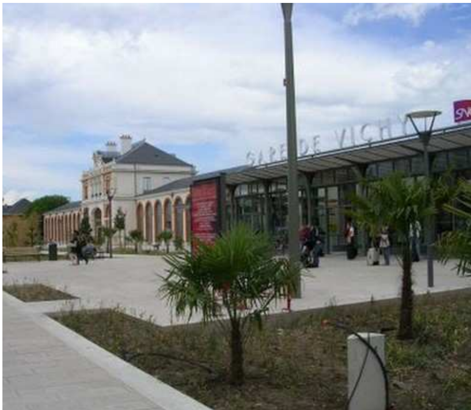
La gare S-N-C-F de Vichy, avec sa façade style Napoléon III et son immense parvis
