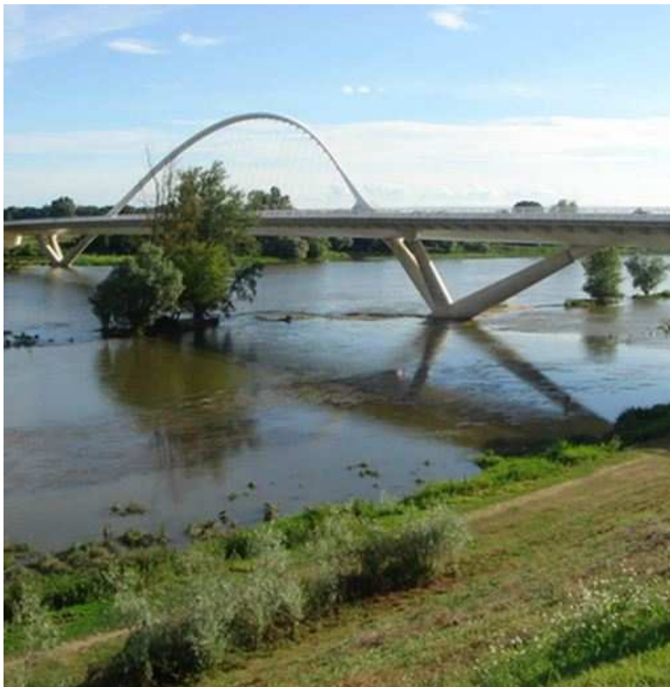
Le pont de l'Europe à Orléans. Ce 5ème pont sur la Loire, a permis de désengorger le trafic Ouest de la cité de Jeanne d'Arc
