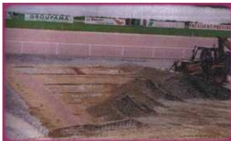
L'hippodrome de Bellevue la forêt à Laval, qui a accueilli ce Championnat entreprise. Quelques travaux de terrassement ont été nécessaires, pour recevoir les pétanqueurs, juste devant la tribune de l'hippodrome Lavallois (photo : La Gazette du Pétanqueur)
