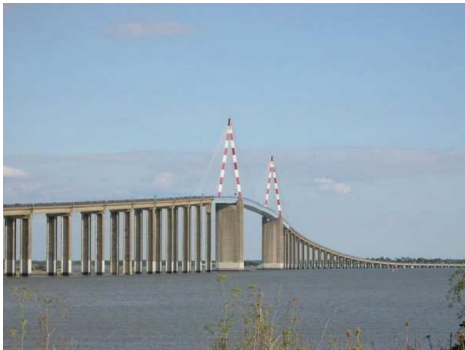
Le pont de Saint-Nazaire, d'une longueur de 3350 mètres et qui enjambe l'estuaire de la Loire et permet de relier Saint-Nazaire et Saint-Brévin-les-Pins
