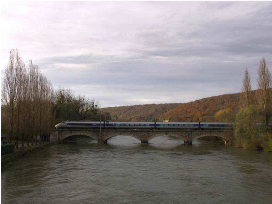
Le pont S-N-C-F de Voujeaucourt, qui permet aux TGV de traverser la rivière Doubs, pour relier Besançon à Belfort
