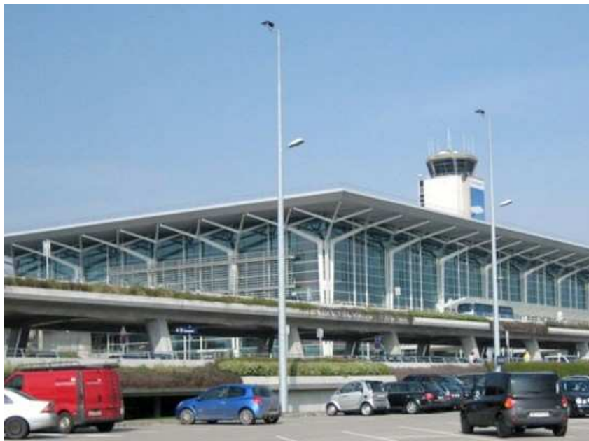
L'Aéroport international de Mulhouse-Bale, implanté proche de Saint-Louis
